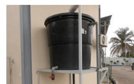
雨水の貯水タンク (ブラザーインダストリーズ テクノロジー(マレーシア))
