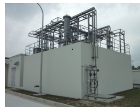
排水処理施設 (ブラザー マシナリー ベトナム)
