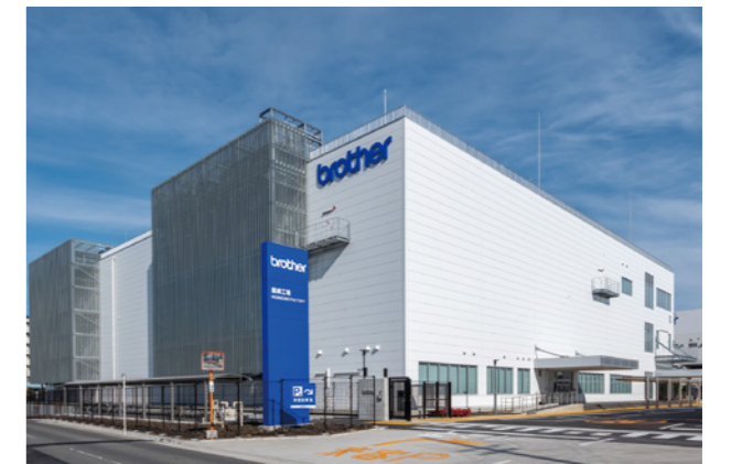
完成した星崎第13工場
