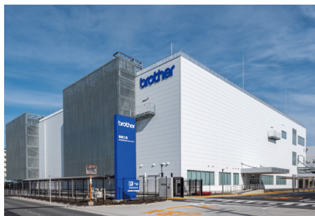
完成した星崎第13工場
