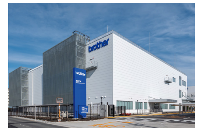
完成した星崎第13工場
