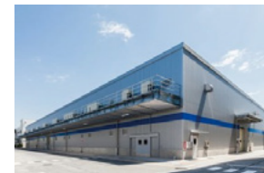
ニッセイ事業 新工場棟「K棟」
