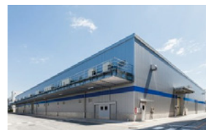
ニッセイ事業 新工場棟「K棟」
