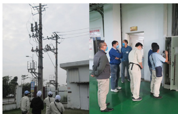
ベトナムでの電気設備監査
