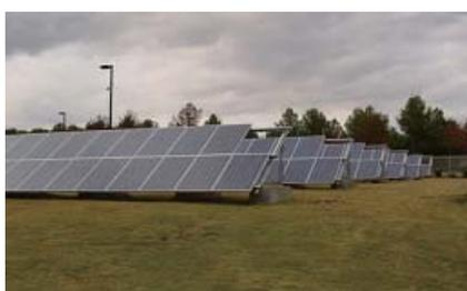
ブラザーインターナショナルコーポレーション(U.S.A.) (以下、BIC (USA)) では、発電能力約60kWの太陽光発電システムを2基導入しています。2012年1月より発電を開始しており、2017年度年間総発電量は193MWhで、この電力量は事業所の約1.9%に相当しています。
