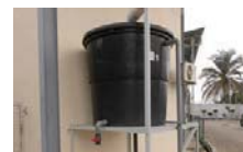
雨水の貯水タンク(台弟工業)
