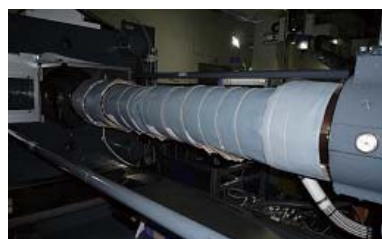
射出成形機のヒーターに保温カバーを設置
