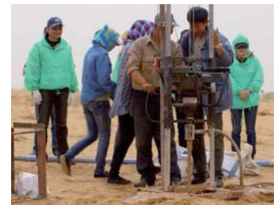
掘削機で井戸を掘る様子
