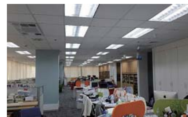
事務所、サービスセンターのLED型蛍光灯
