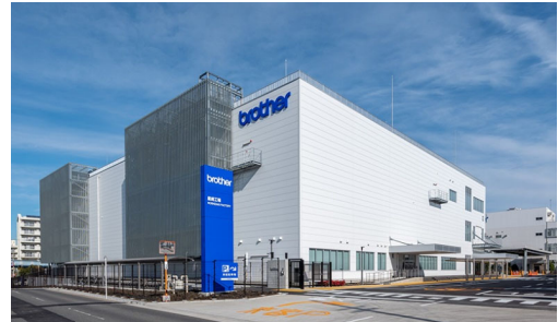
星崎工場 新工場棟（第13工場）
