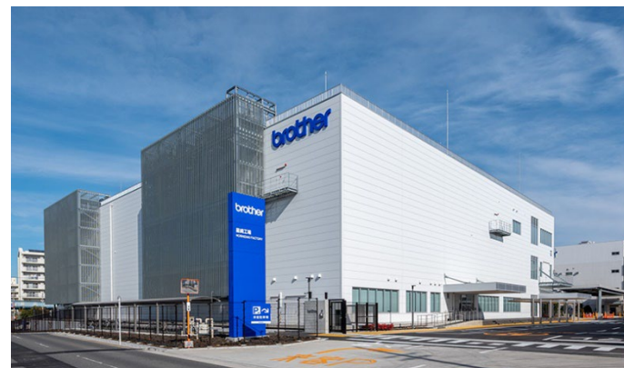
星崎工場 新工場棟（第13工場）
