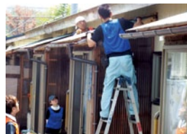
▲ 風除室補修作業
